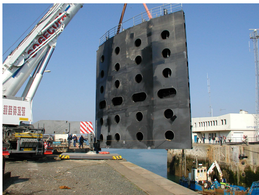
La mise en place du vantail en avril 2003
