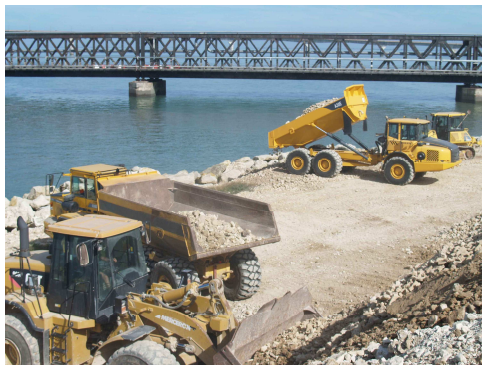
La Repentie : démarrage des travaux le 14 septembre 2010.
