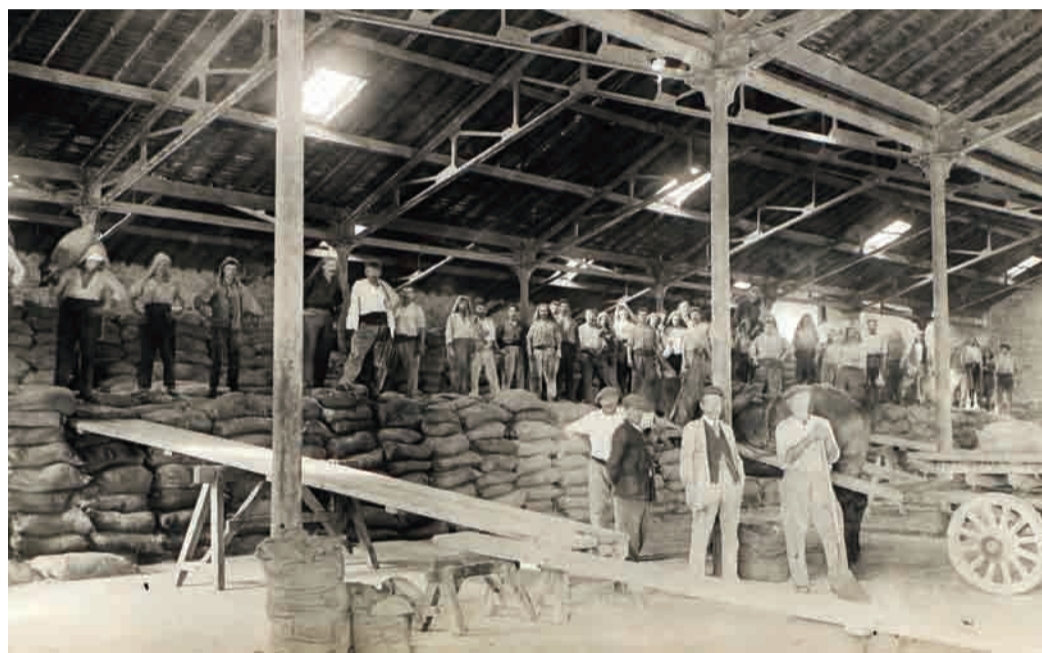
La construction d'un des deux radoub (en haut). Ouvriers affectés au déchargement des navires (en dessous). Photos DR
