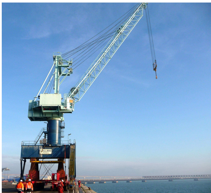
8 h 55. La grue sur son nouveau quai, le Môle Est.
