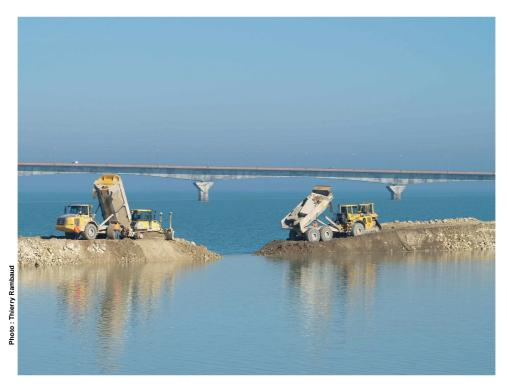
La digue désormais fermée, le remplissage du casier va pouvoir débuter. Pour ce faire, le Port recycle les produits les plus nobles issus du BTP conformément à sa politique de développement durable.
