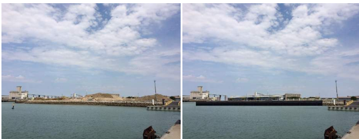
Figure 14 : Vues de Chef de Baie 4 avant et après travaux (PALR)
