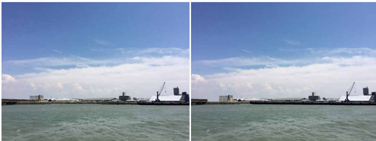
Figure 13 : Vues de l'Anse Saint-Marc 3 avant et après travaux (PALR)
