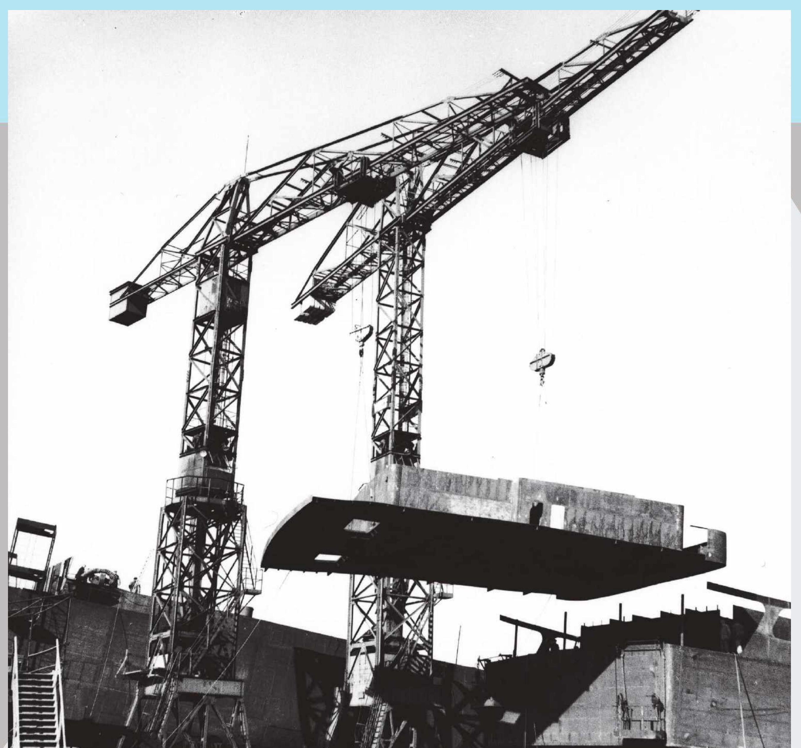
Montage d'un élément préfabriqué aux Chantiers Navals en 1961 Fonds PDR 09205
