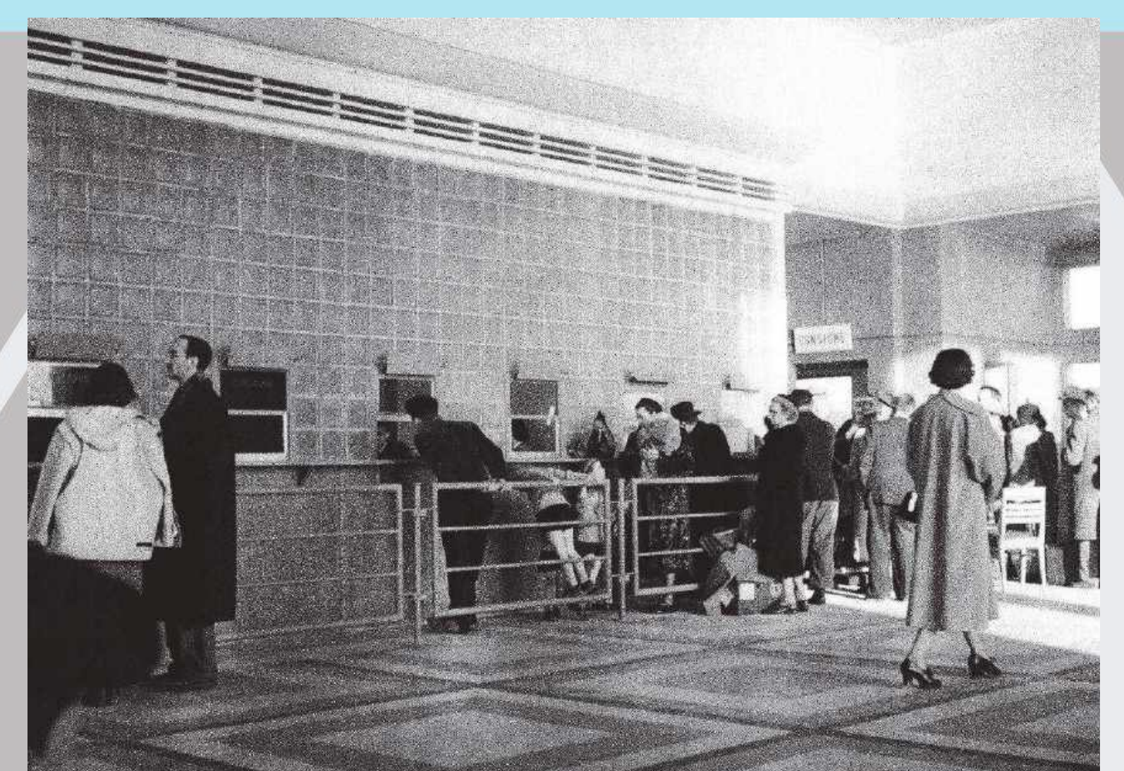
Vue intérieure de la gare maritime Fonds PDR 05117
