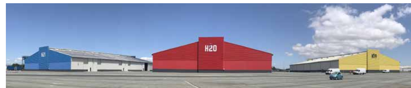
Mise en peinture des hangars 19 à 21 depuis Chef de baie.
