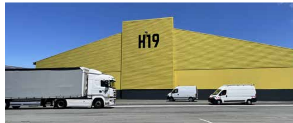
Exemple voie d'exploitation terre plein H19
