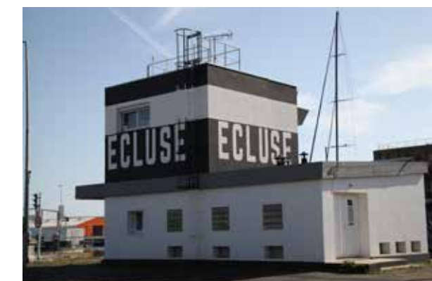
Requalification de l'ancienne écluse
