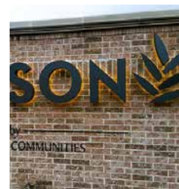
Illustration d'enseigne en lettres découpées et rétro-éclairées.
