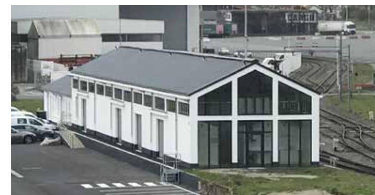
Requalification de la gare de La Pallice
