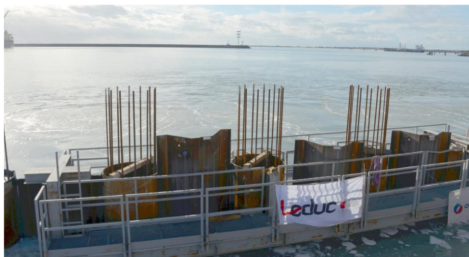
Figure 24 : Déploiement d'un rideau à bulles à l'avancement
