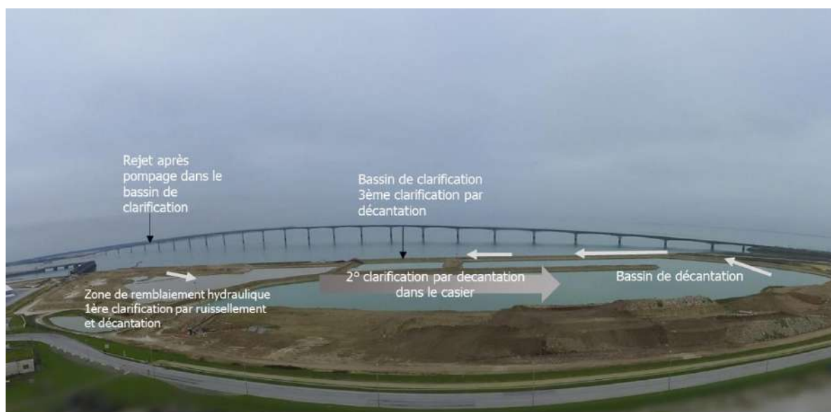
Figure 10: Zone de la Repentie aménagée
