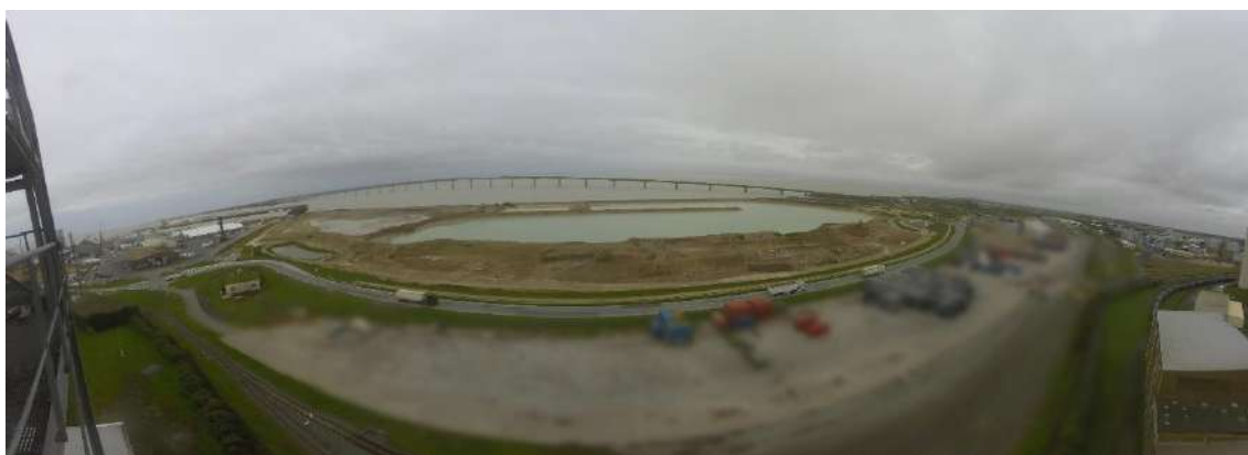
Figure 18 : Photographie du bassin de décantation à partir du time-laps (12 mars 2024)
