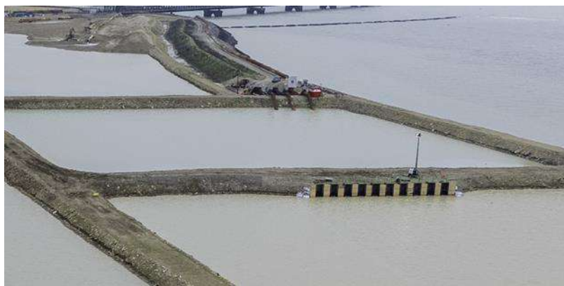
Figure 11: bassin de clarification et rejet
