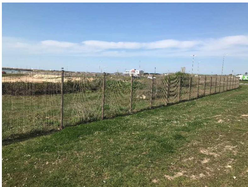
Figure 15 : Nouvelles clôtures mise en place début 2021, le long de la zone d'évitement
