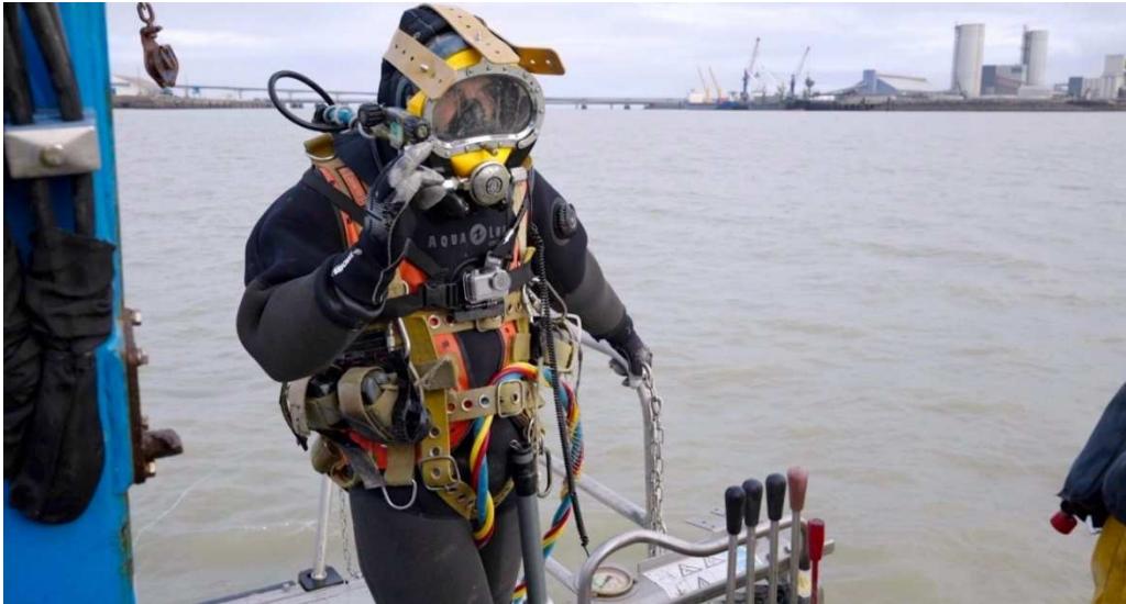
Figure 5 – Plongeur-scaphandrier-démineur de la société Vinci Construction Maritime avant plongée pour l'identification d'une cible dans la zone d'approfondissement du Chenal d'Accès © Jean-Dominique Lamy, 01/2021
