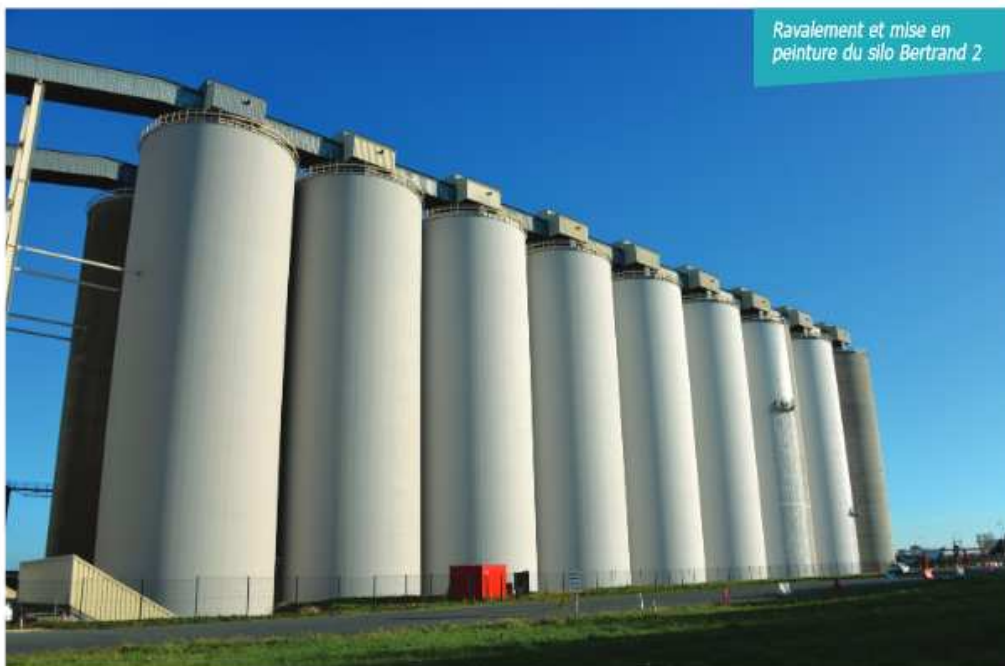
Figure 32 : Ravalement et mise en peinture du silo Bertrand 2
