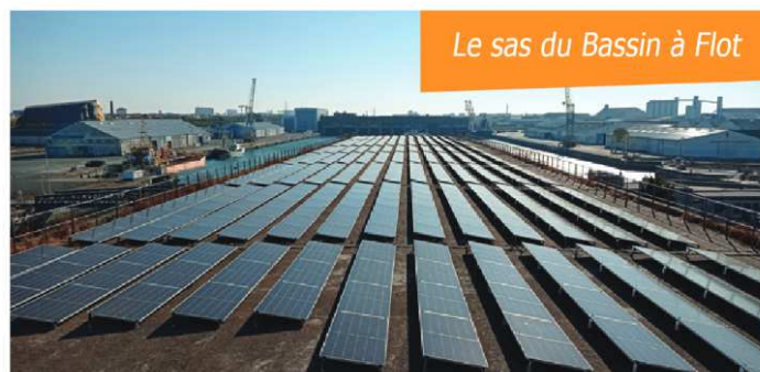
Figure 29 : Photographie du SAS couvert du Bassin à Flot solarisé
